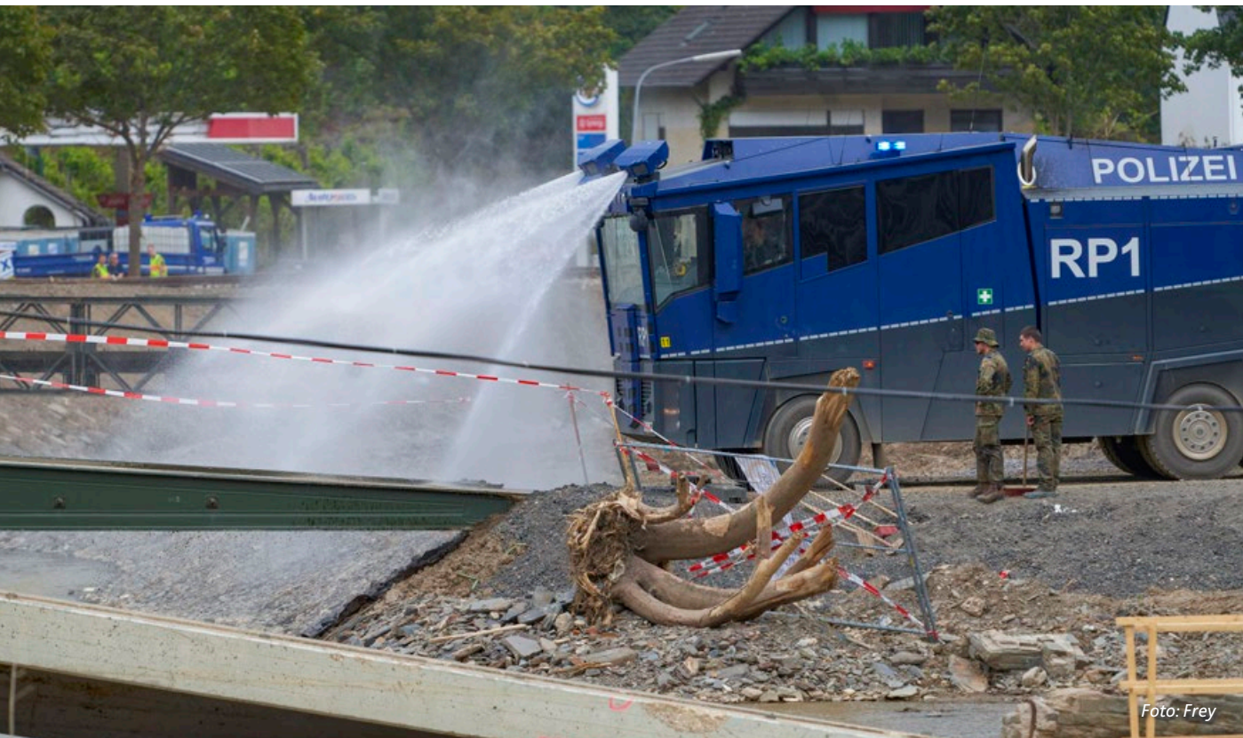
Ein Wasserwerfer der Polizei hilft bei Reinigungsarbeiten.
