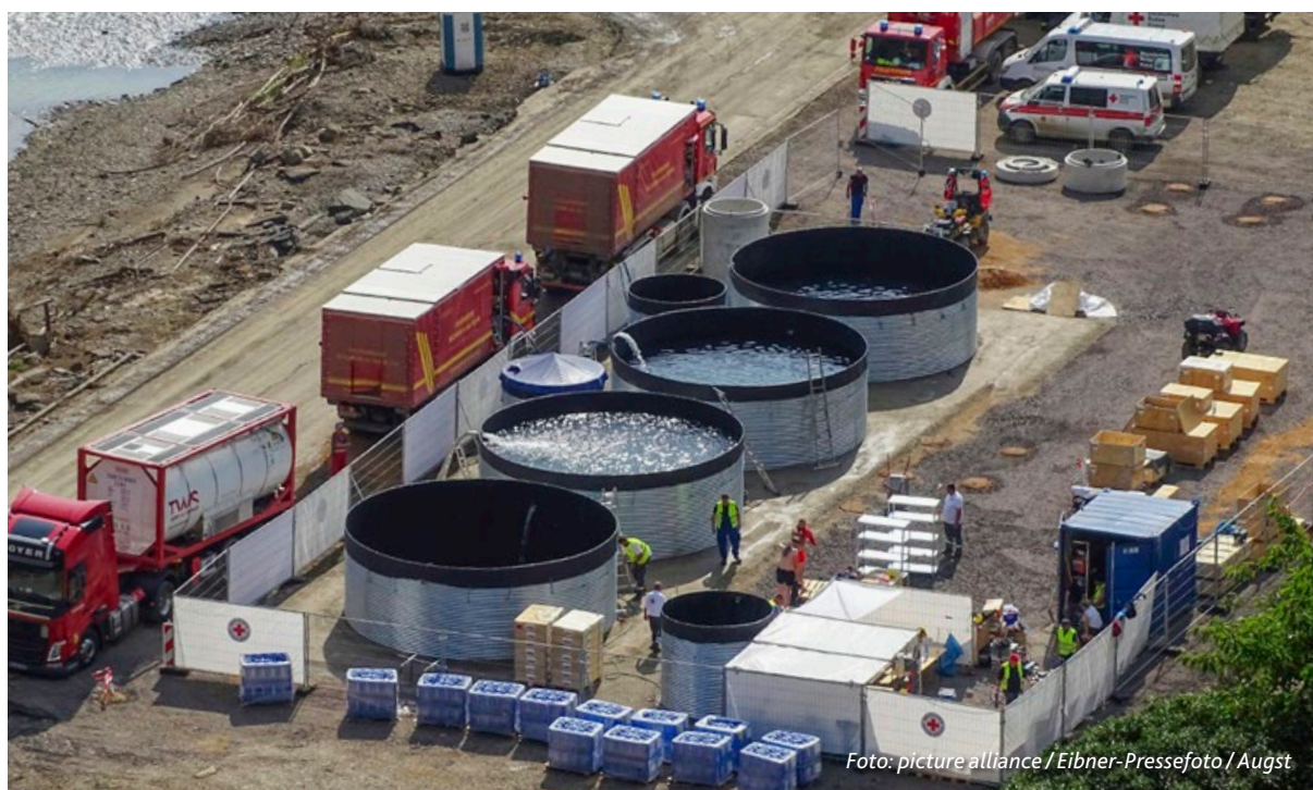
Blick auf die Behelfskläranlage in Mayschoß (Ahr). Die mobile Anlage wurde vom Deutschen Roten Kreuz aufgebaut und ist die erste in Deutschland.
