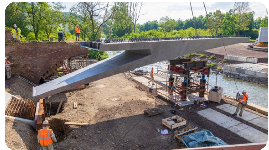
Montage eines Segments der neuen Heppinger Brücke in Bad Neuenahr-Ahrweiler am 6. Mai 2025.
