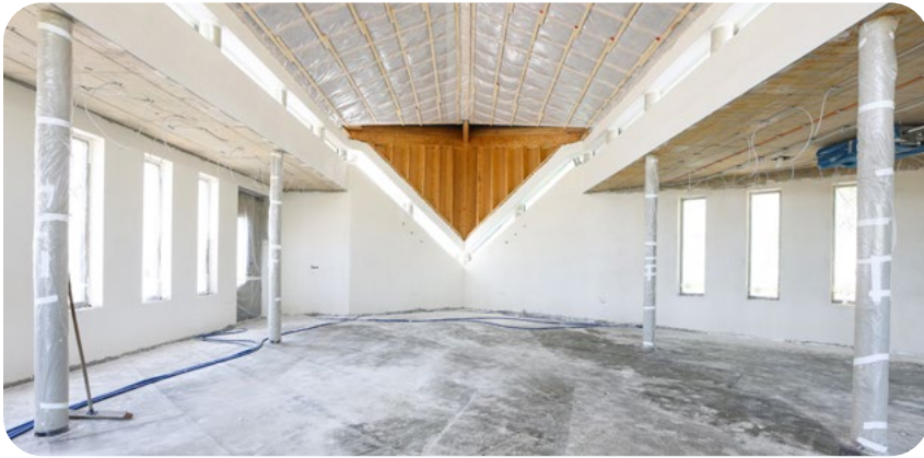
Blick in den Innenraum der im Bau befindlichen Aussegnungshalle
