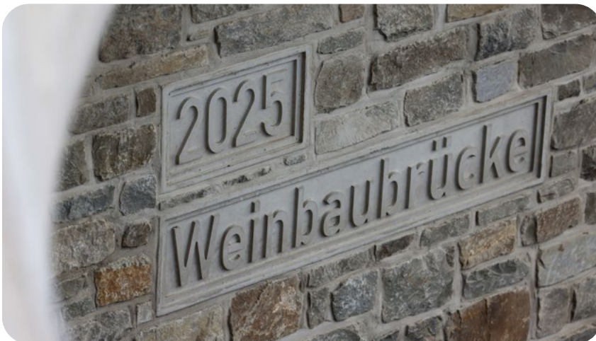
Teile der Weinbaubrücke sind mit Naturstein verkleidet.
