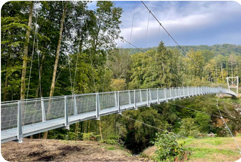
Die neue Irreler Hängebrücke überspannt mit einer Länge von 110 Metern das Prümtal.
