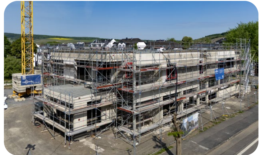
Die Kita Blandine-Merten-Haus wird mit einer zusätzlichen achten Gruppen neu wiederaufgebaut.
