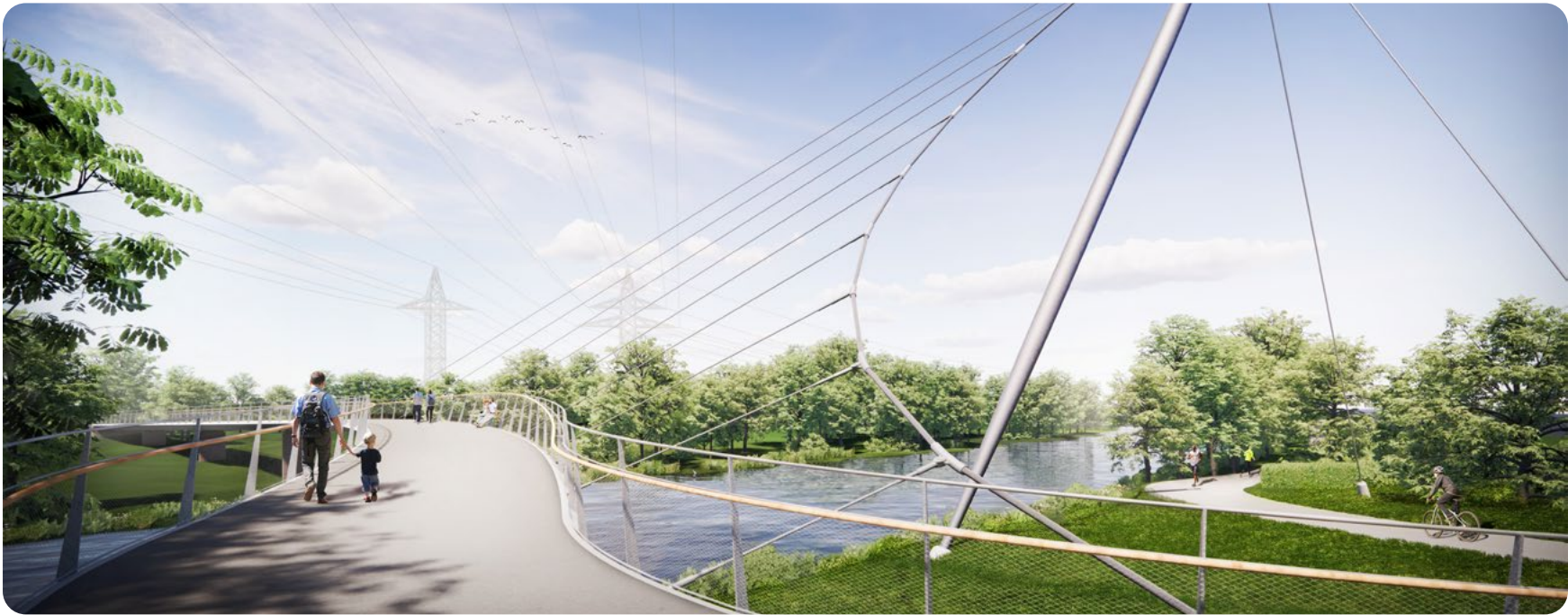
Der Spessartsteg in Sinzig wird als Schrägseilbrücke mit einem Pylonen errichtet. © Werner Sobek AG
