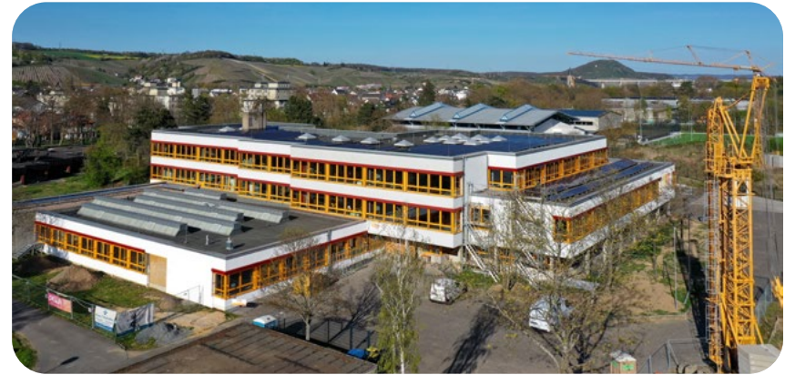
Die Sanierung der Erich-Kästner-Realschule plus erfolgt im laufenden Betrieb.
