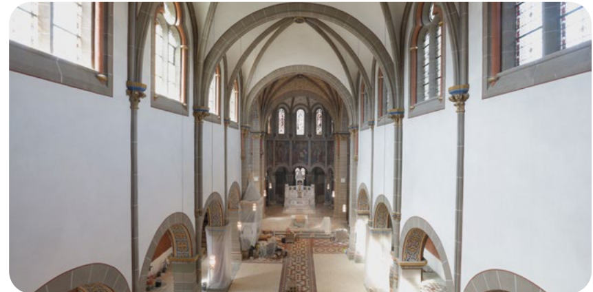
Der Sanierung des Innenraums der Rosenkranzkirche ist bereits weit fortgeschritten.
