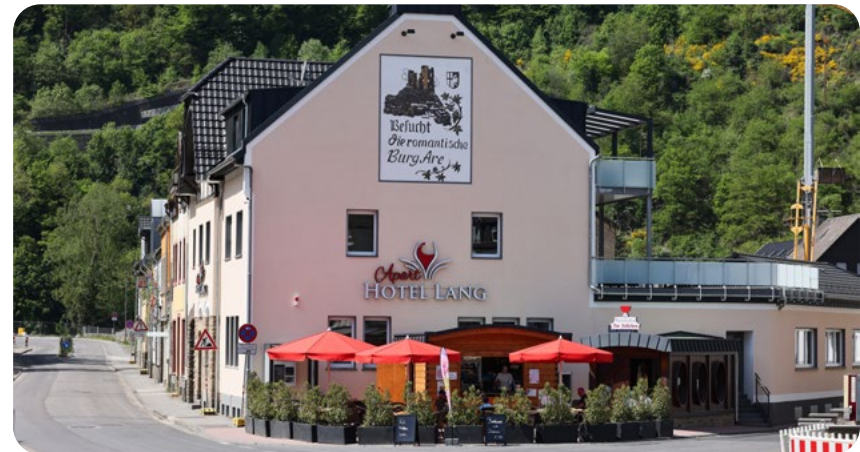
Auch das Hotel Lang in Altenahr hat wiedereröffnet.
