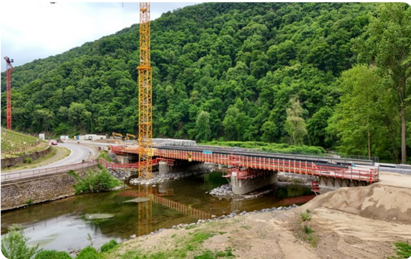
13 neue, hochwasserresiliente Brücken entstehen entlang der Ahrtalbahnstrecke.
