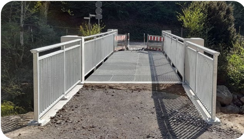
Die neue Brücke über die Nette schließt eine Lücke im Traumpfad Förstersteig.
