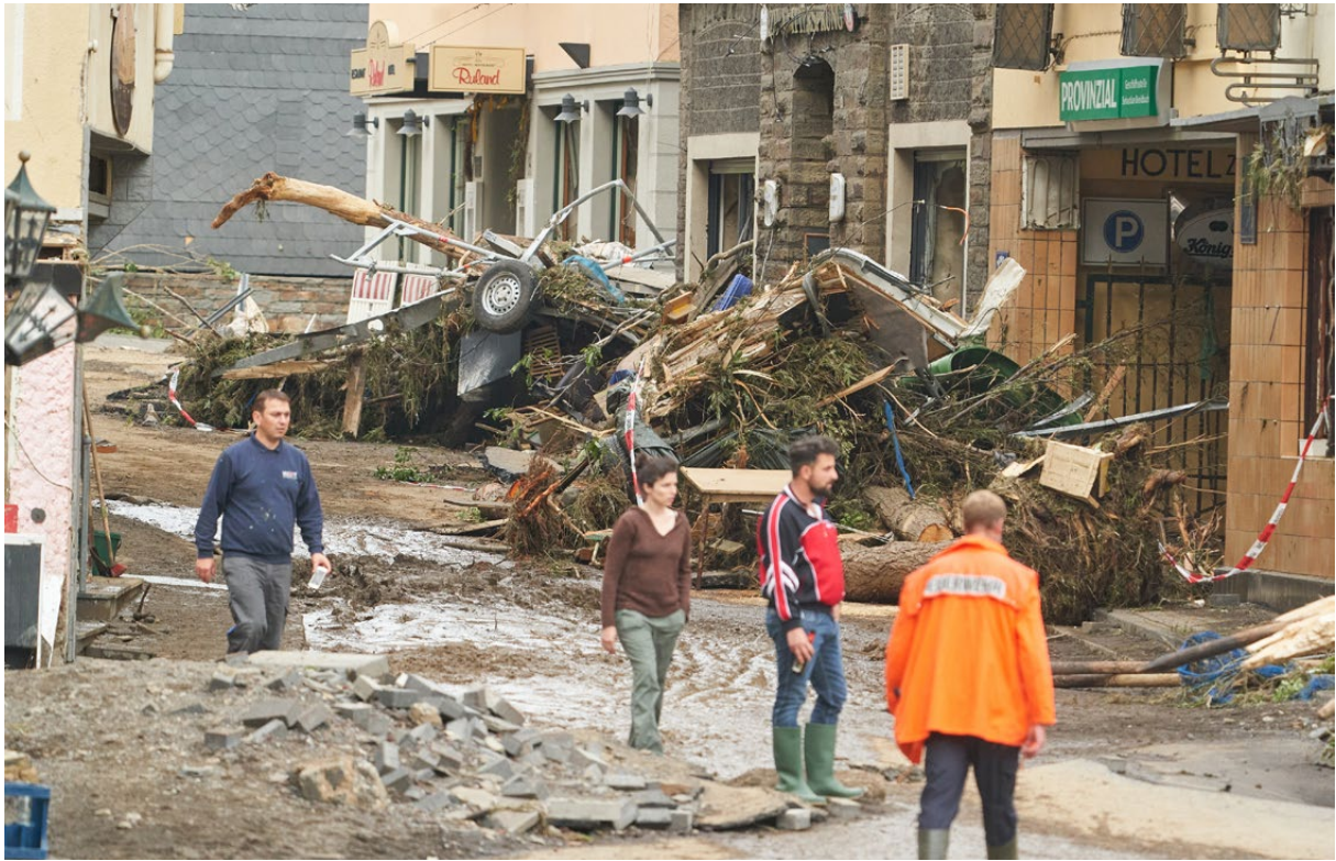
Meterhoch türmte sich der Schutt in den Straßen.
